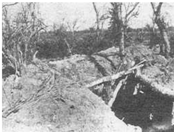
Una trinchera en el Chaco
